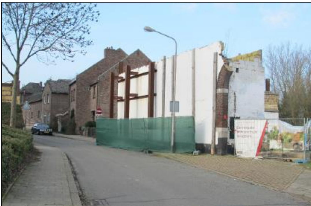
De Pletzersstraat in noordelijke richting, met aan de rechterzijde de hoekgevel gelegen binnen het plangebied
